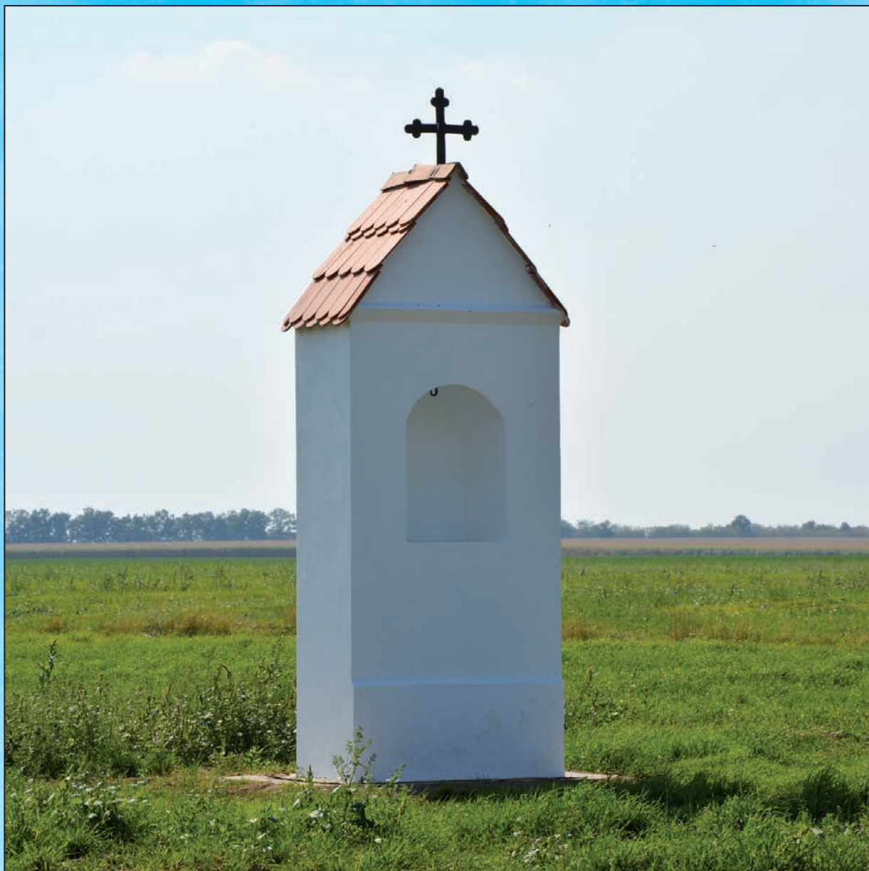
Nově opravená kaplička v Českých Křídlovicích.
