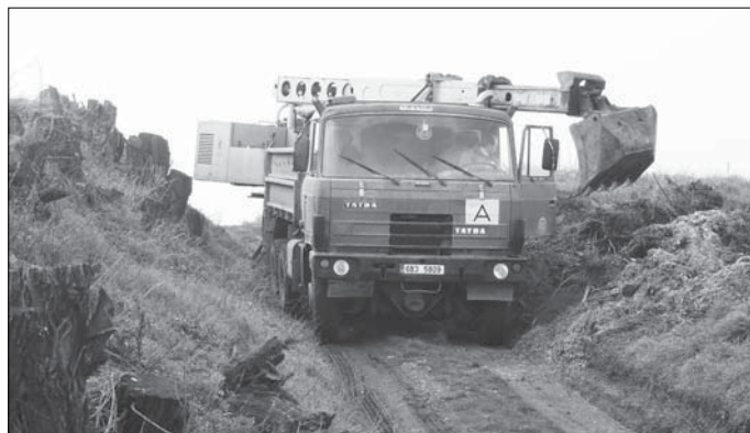
Odtěžení pařezů, prohloubení a rozšíření úvozu.
