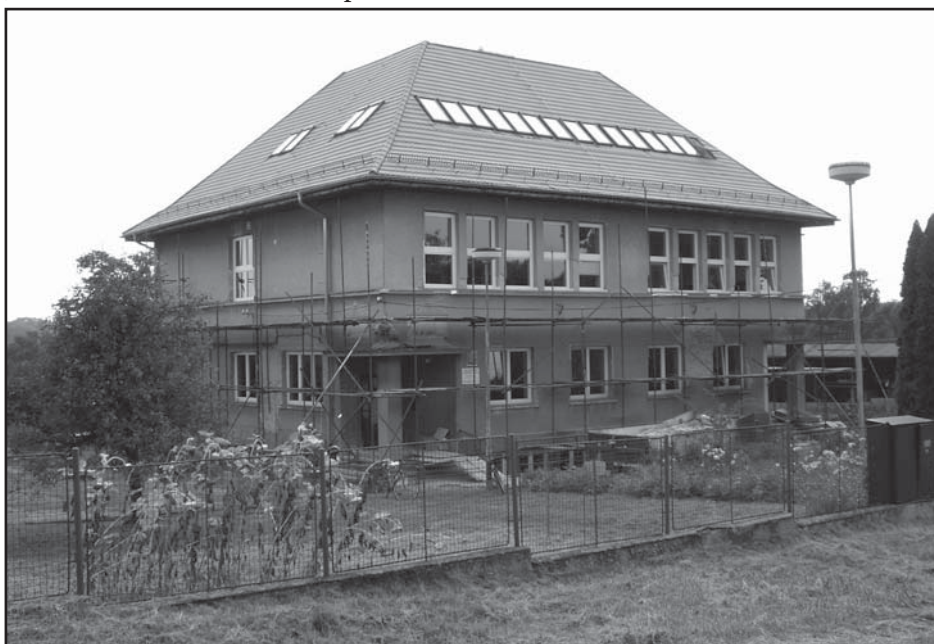
Oprava budovy základní školy
