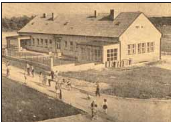
Pohled na budovu tehdejších jeslí.
